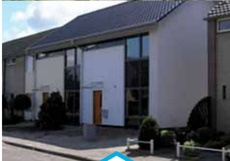
Passivhaus Roosendaal (Niederlande)
