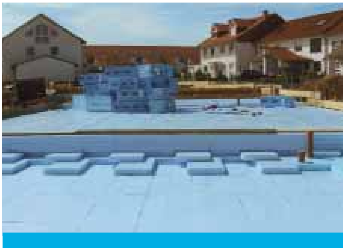
Abb. 05: Passivhaus mit hochgedämmter Fundamentplatte
