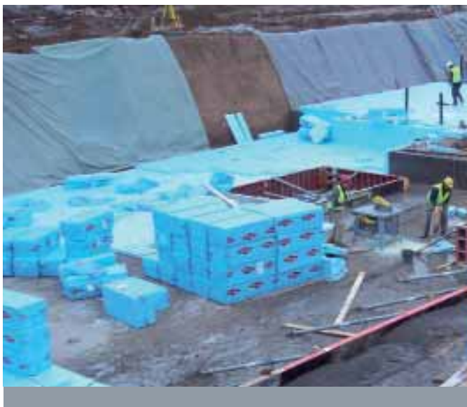
Abb. 22: Philipp-Reis-Schule mit Passivhaus Sporthalle im Bau
