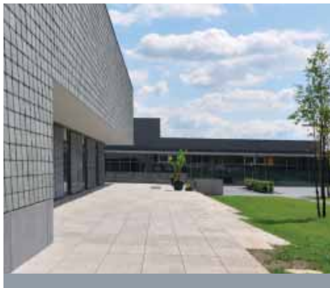
Abb. 23: Philipp-Reis-Schule mit Passivhaus Sporthalle nach Fertigstellung
