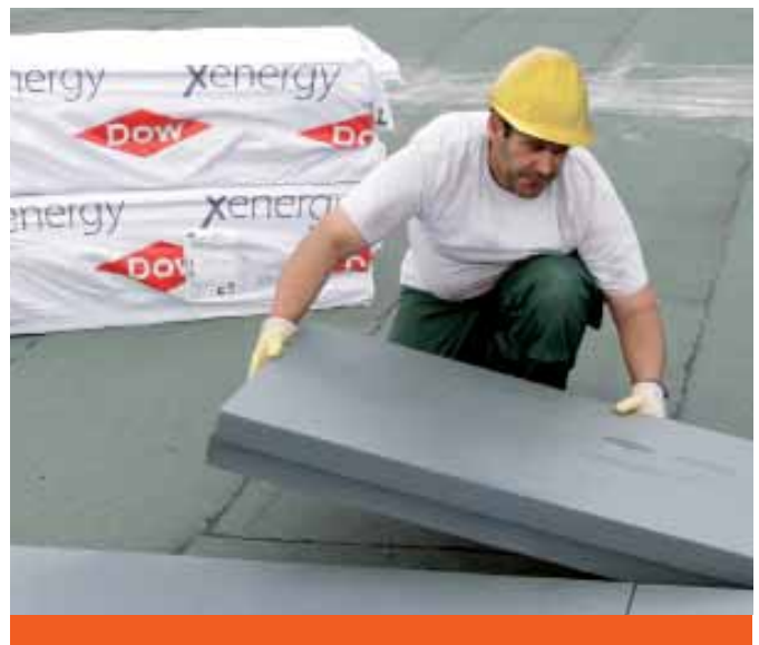
Abb. 19: Zweilagige Verlegung im Umkehrdach mit XENERGY™ (wie in Abb. 18) erfüllt die Passivhaus-Anforderung
