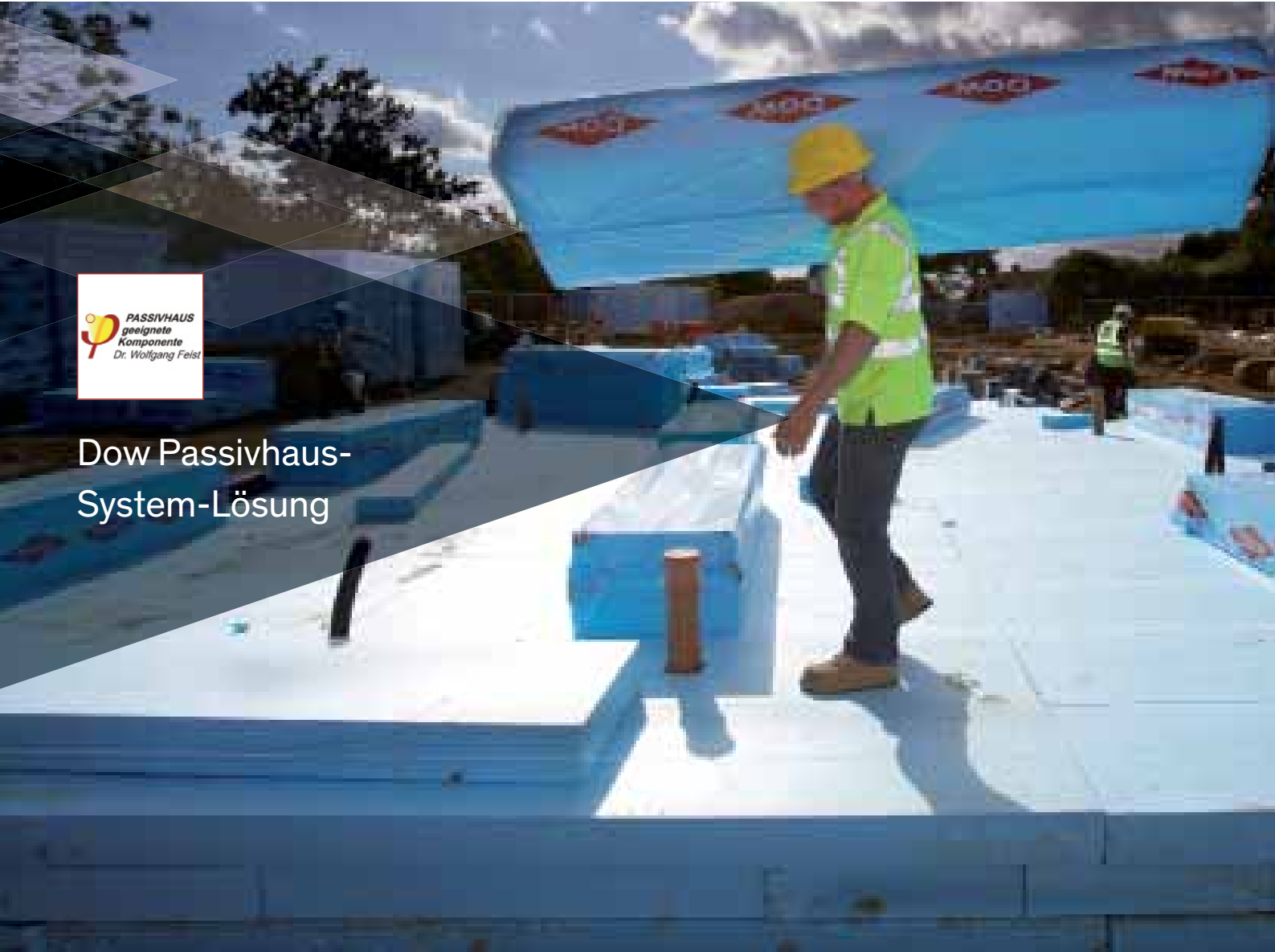
Abb. 08: Bis zu dreilagige Verlegung gemäß allgemeiner bauaufsichtlicher Zulassung möglich: ROOFMATE™ SL-A, FLOORMATE™ 500-A und FLOORMATE™ 700-A
