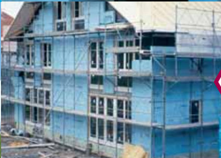
Minergie Haus Wädenswil (Schweiz)
