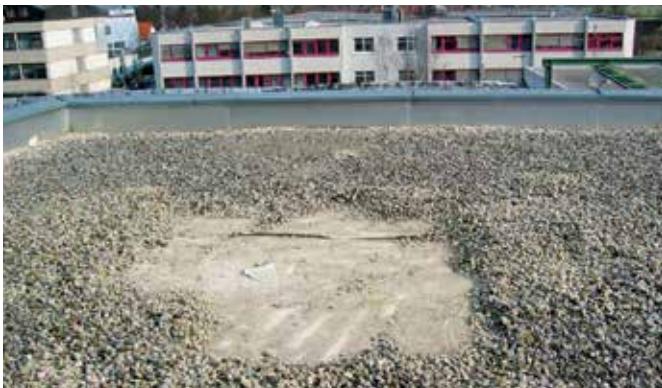
Bild 06: Versuchsdach mit teilweise freigelegter Trennlage
