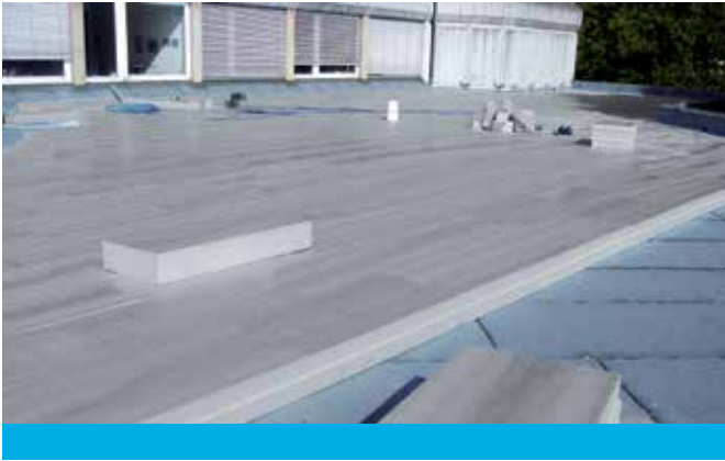
Bild 11: PLUS-Dach Sanierung mit XENERGY™. Dämmplatten werden auf das vorhandene Dach lose verlegt.
