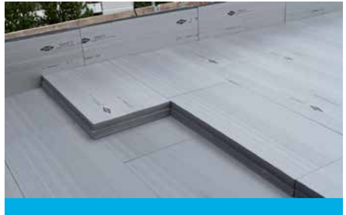
Bild 12: Zweilagig verlegtes Umkehdach mit XENERGY™
